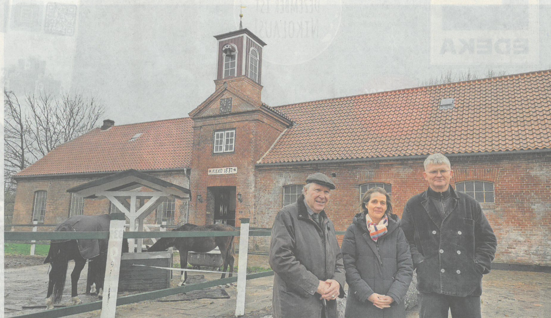
Der Glockenturm strahlt in neuer Frische: Für Ortskurator Wolfgang von Ancken, Gutsverwalterin Cornelia von Buchwaldt und Zimmerermeister Oliver Steen (von links) sind die Sanierungsarbeiten nun abgeschlossen.
