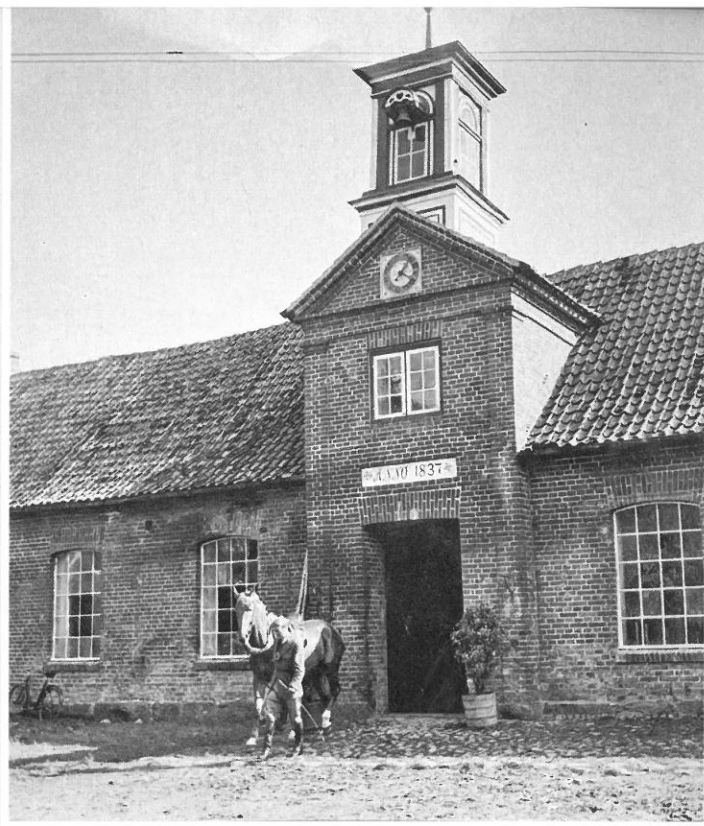
Ein Bild aus vergangenen Tagen: In diesem Pferdestall waren einst einige der berühmtesten Springpferde Deutschlands untergebracht. Im vergangenen Jahr wurde der Stall aufwendig saniert.
